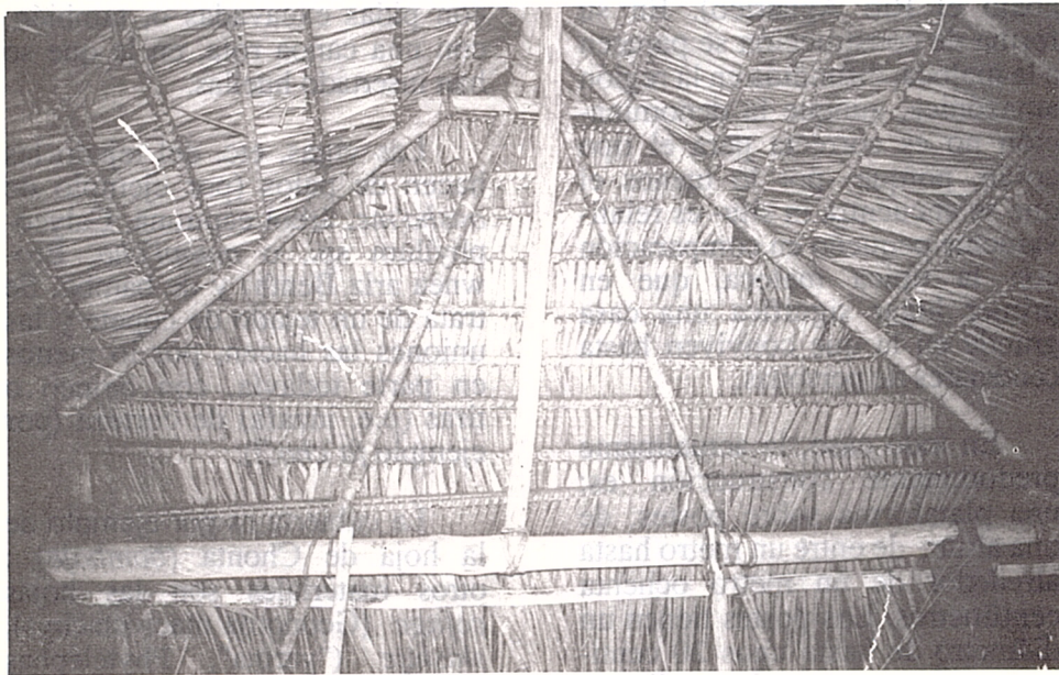
Construcción del techo
